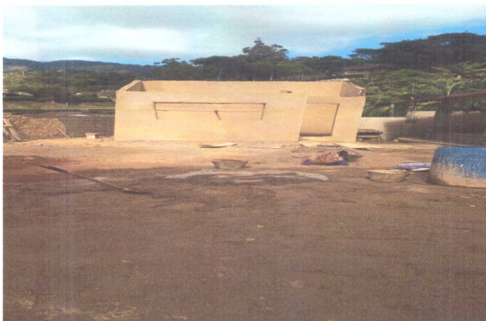
EMBOÇO DA SALA DO MATERNAL E BANHEIRO
