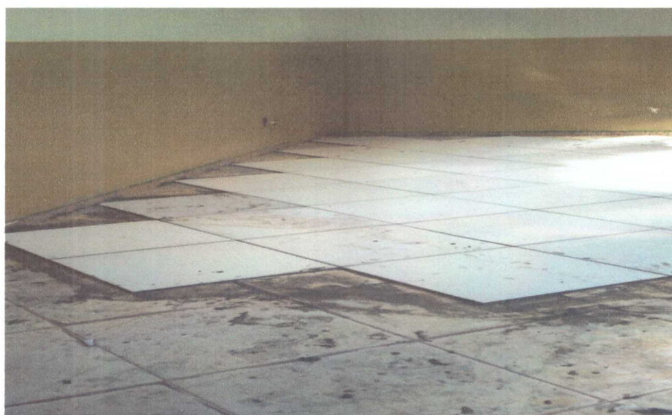
ASSENTAMENTO DE REVESTIMENTO DO PISO
