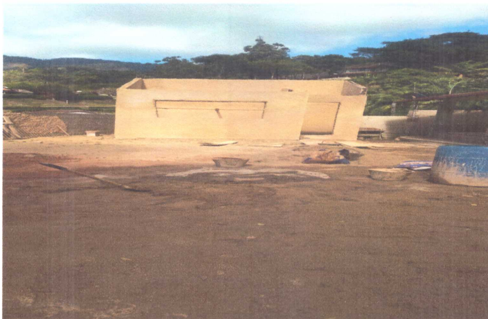
EMBOÇO DA SALA DO MATERNAL E BANHEIRO
